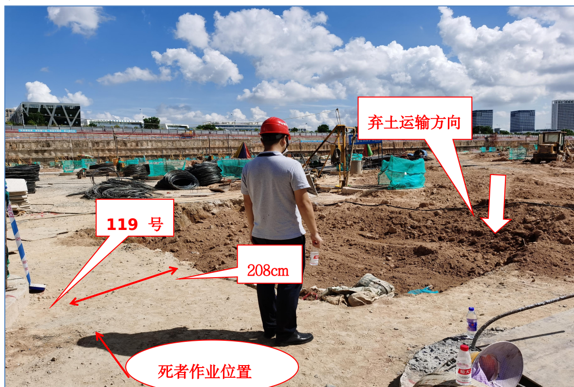
图 2 作业位置与渣土坑及 119 号桩孔关系
