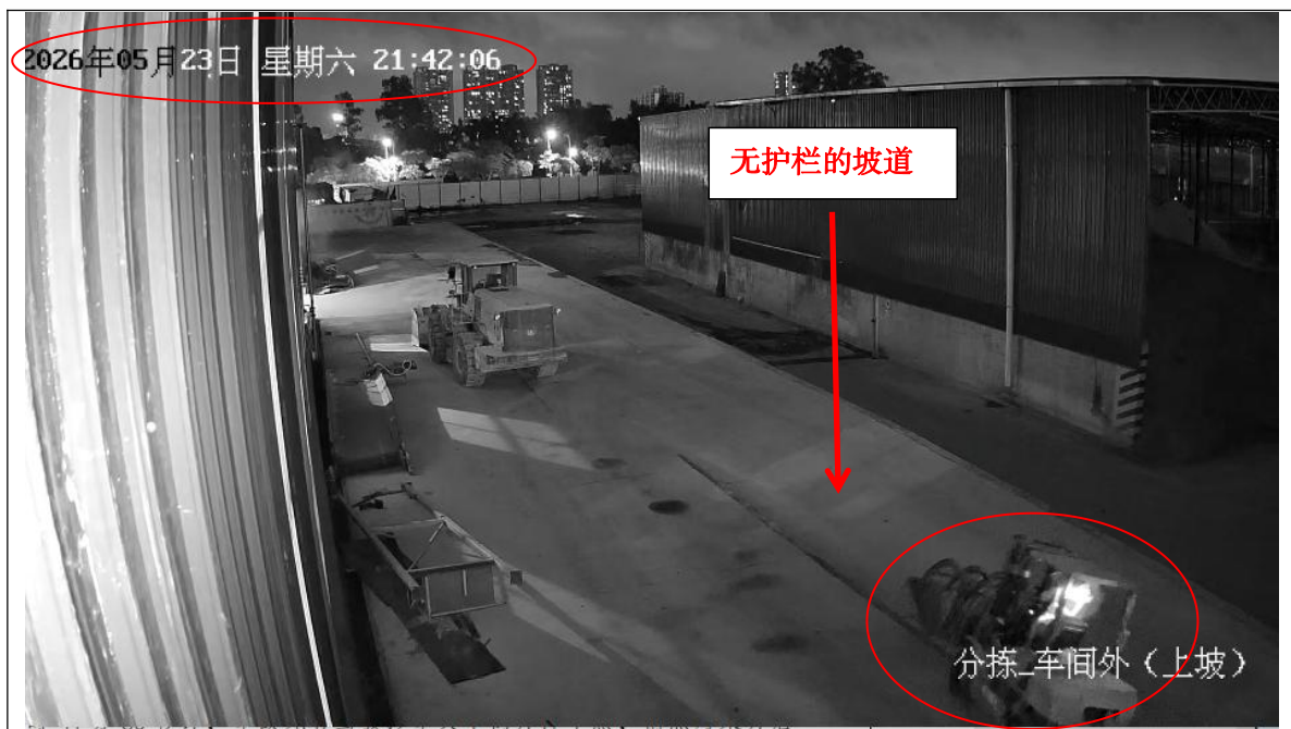
图 3 21 时 42 分 06 秒许，涉事场（厂）内车辆跌落临边无护栏的坡道发生侧翻事故
