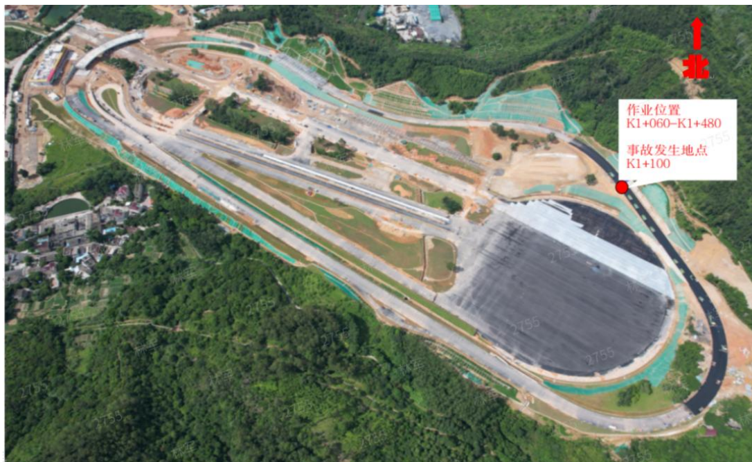
图 1 项目工地现场情况
