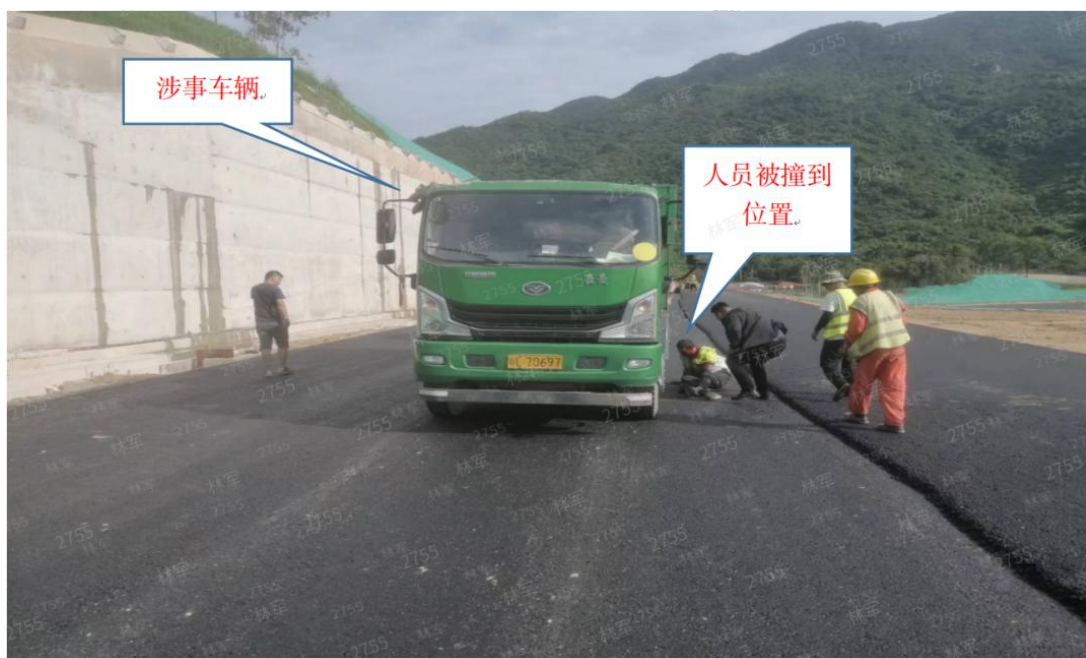
图 2 事发位置现场情况
