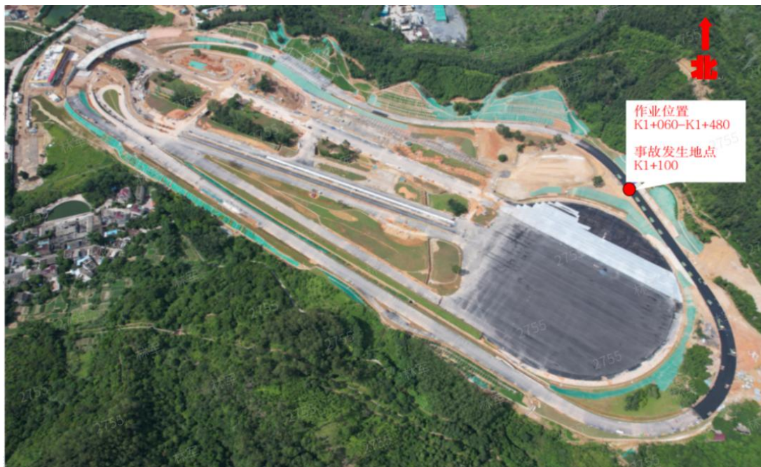
图 1 项目工地现场情况
