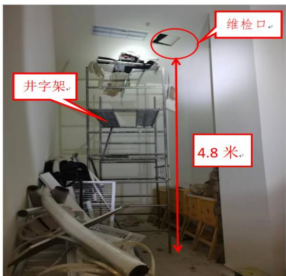
图 2 2 号体育设备器材室现场情况
