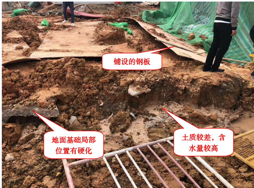
图 3 旋挖钻机位置地面地质情况
