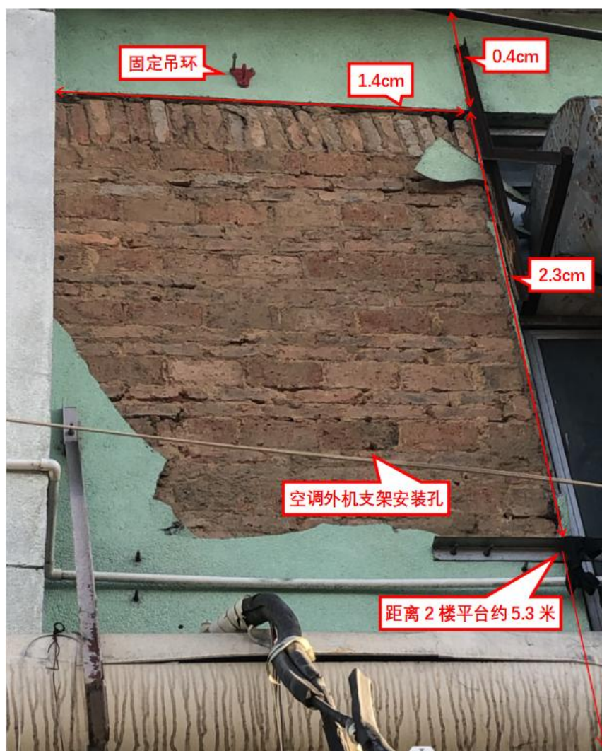
图3 空调外机安装位置外墙情况
