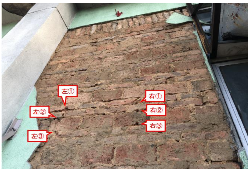
图4 外墙上空调外机支架安装孔对应情况
