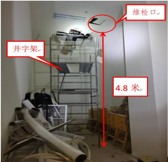
图 2 2 号体育设备器材室现场情况
