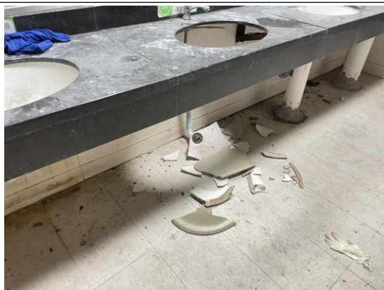
图 2 醋酸正丙酯包装桶飞出击破洗手池
