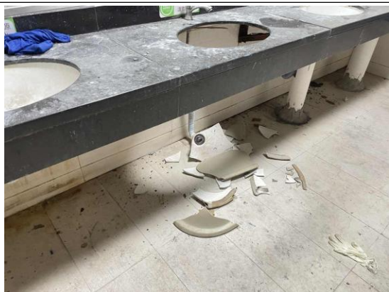
图 2 醋酸正丙酯包装桶飞出击破洗手池
