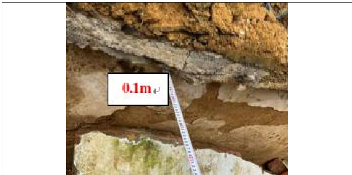
图 5 墙与地面间隙 0.1m
