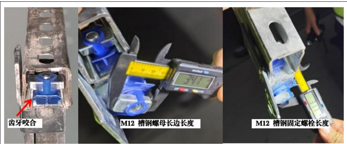
图 9 M12 槽钢螺母紧固情况
