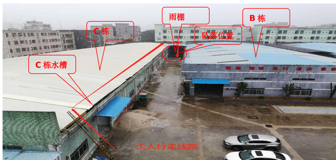
图1 作业人员行走线路
