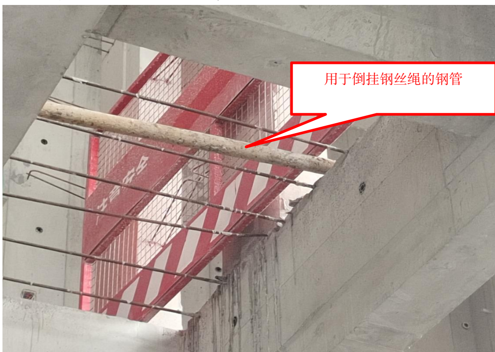
图 1 十楼通风管道口脚手架钢管
