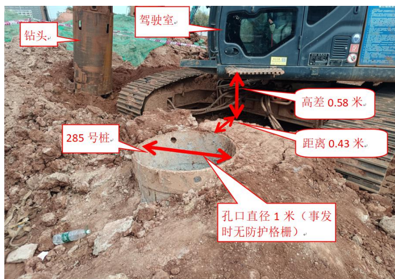
图 1 某某路涉事项目工地 285 号桩现场情况
