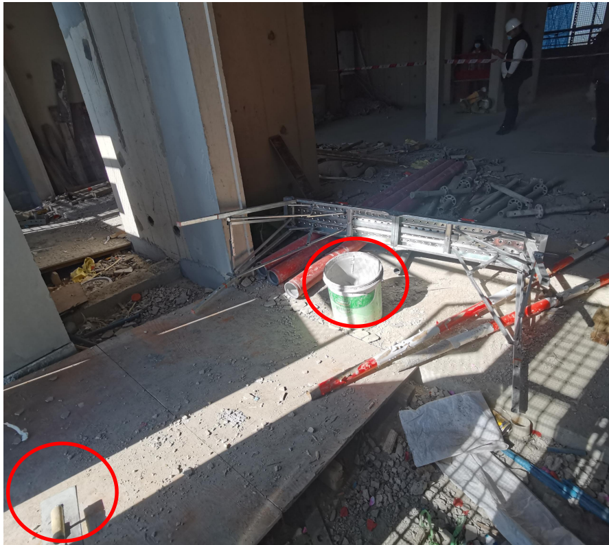
图 1 斜坡上放有一桶未使用完的水泥砂浆和一把水泥批刀
