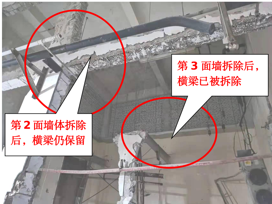
图 5 工具房隔墙横梁现场情况
